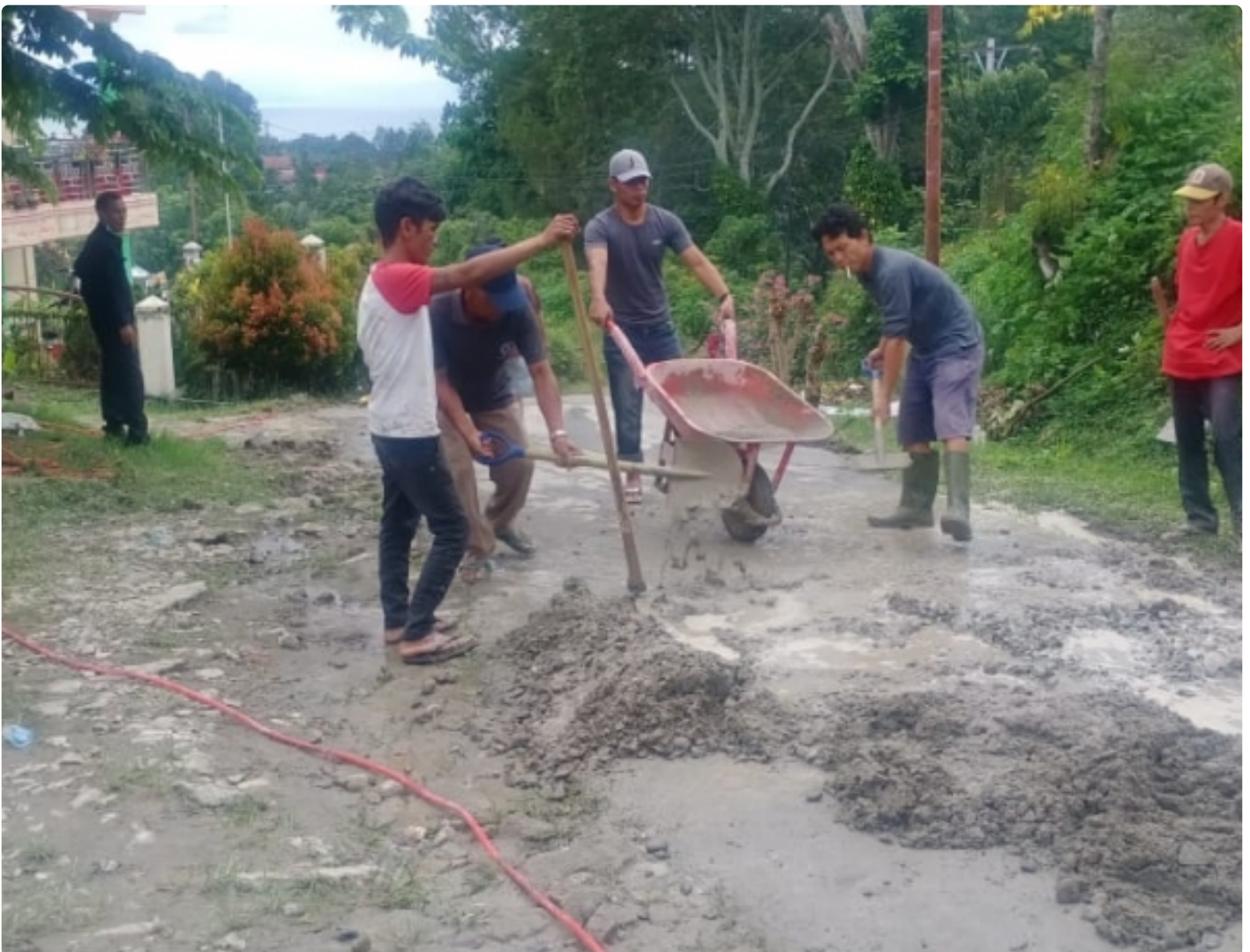
Masyarakat Kabupaten Toba Perbaiki Jalan Rusak Milik Kabupaten Simalungun
