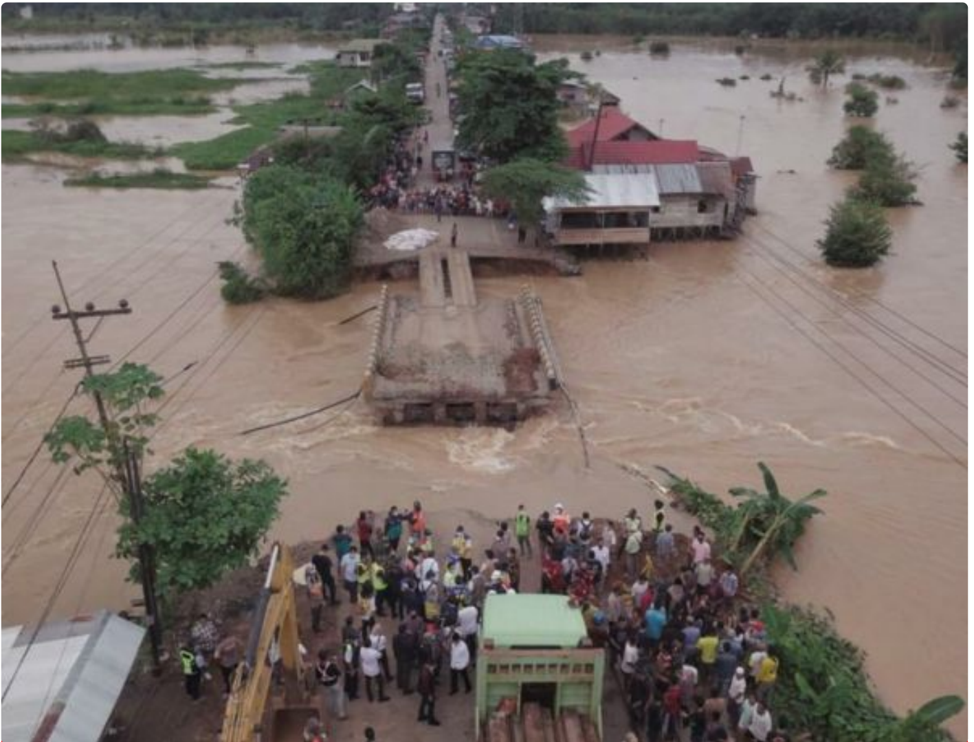
Menteri PUPR: Tiga Hari Pemasangan Jembatan Bailey Kalsel-Kaltim Selesai
