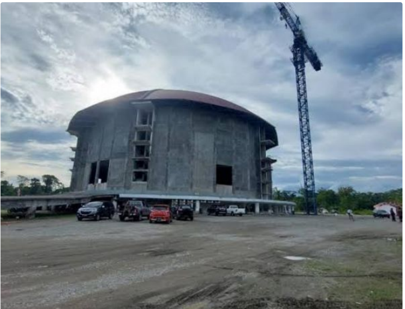
Pembangunan Gereja Kingmi Mile 32
