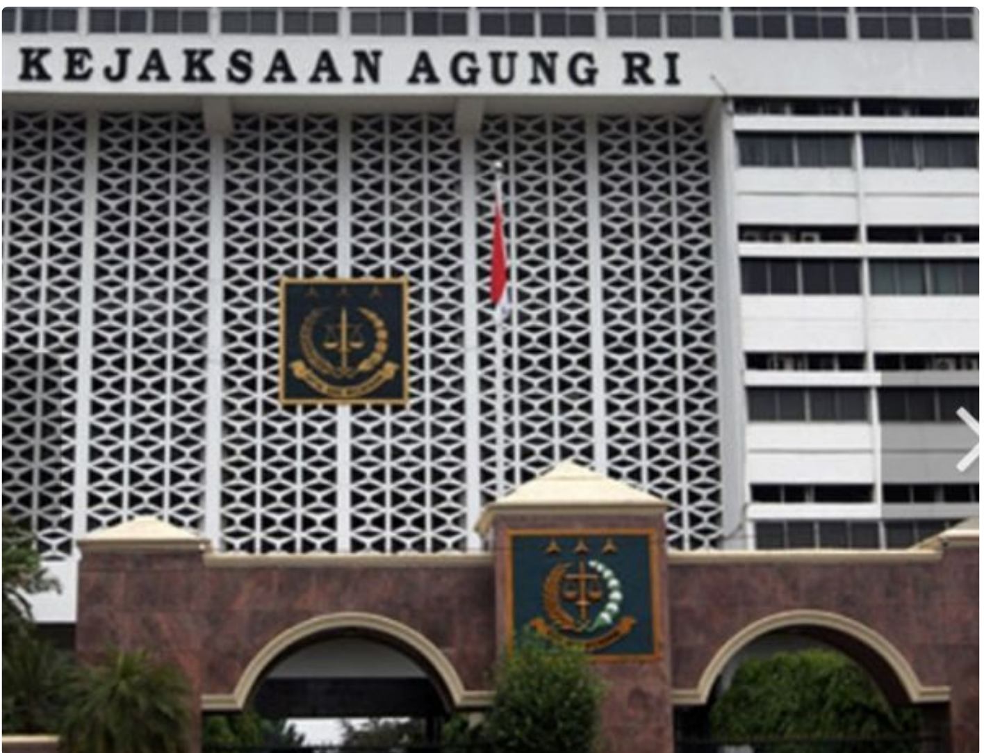
Photo : Gedung Kejaksaan RI
