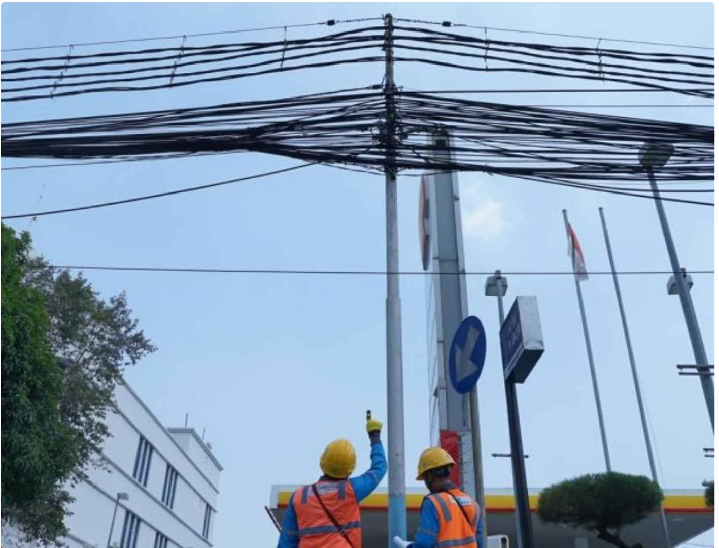
Photo: Titik Lokasi pencuri Kabel PLN
