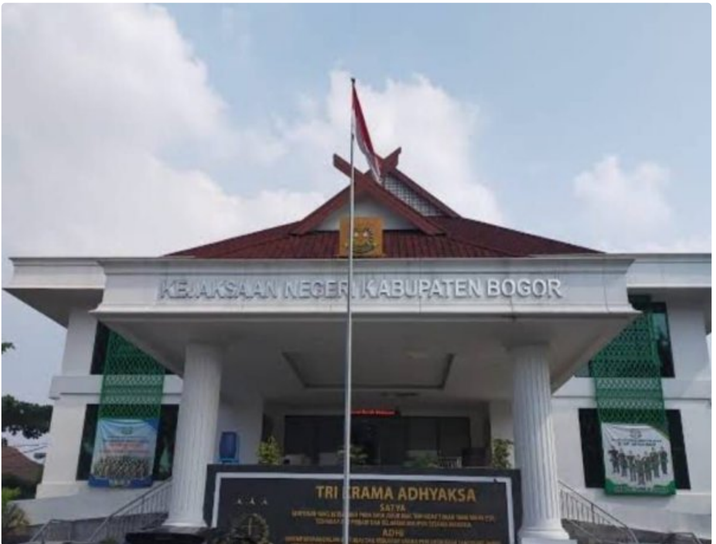
Photo : Gedung Kejari Kabupaten Bogor
