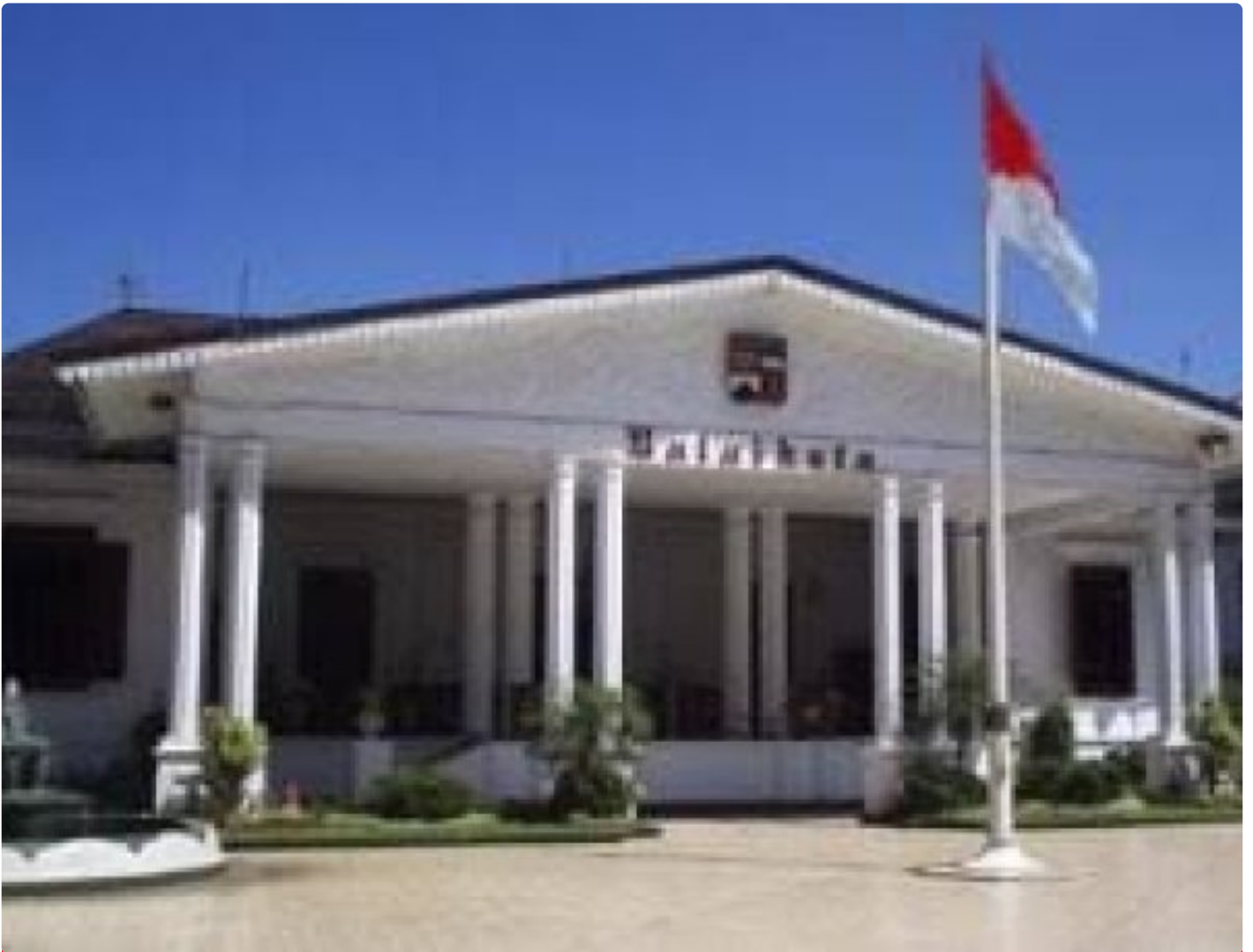
Photo Gedung Wali Kota Bogor
